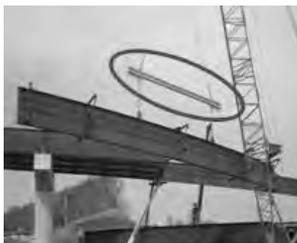
Fig. 2: Spreader Beam
